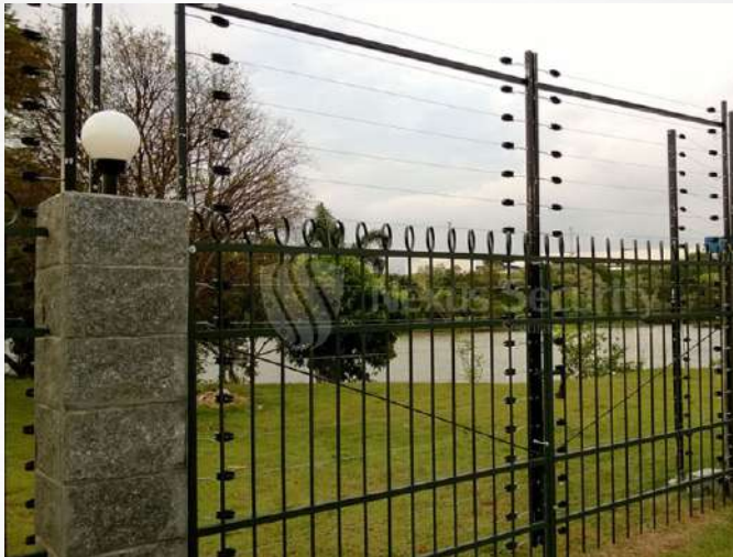
Inst. de cerca elétrica Speedrite (4Km) em cond. horizontal em Itú
