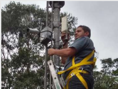
Inst. de câmeras IP em condomínio de alto padrão no SBC.
